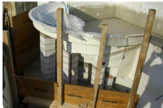
**ACHTUNG:** Überprüfen sie dass die Treppe oben exakt waagrecht sitzt – erst danach darf mit Beton hinterfüllt bzw. hintermauert und weitergemacht werden! Wenn der Unterschied in der Waage weniger als 3cm ist -> drückt man diese per Hand in die richtige Position!
